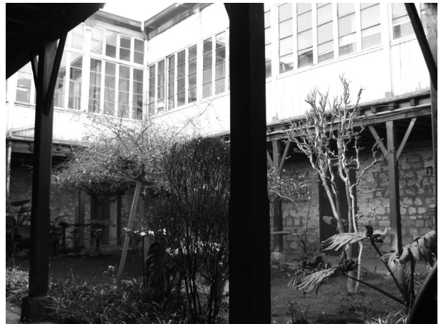
Figura 1. Uno de los patios interiores del Hospital Parroquial de San Bernardo.
