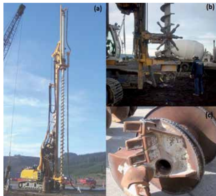
Figura 2: a) Ejecución pilote CFA de 18 m (Pilotes Terratest, 2009), b) limpieza de hélice (Pilotes Terratest, 2009) y c) punto de descarga de hormigón en el fondo (Brown et al. , 2007)
