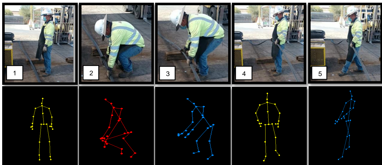
Fig. 4: Principales posiciones durante el proceso de doblado de varilla.
