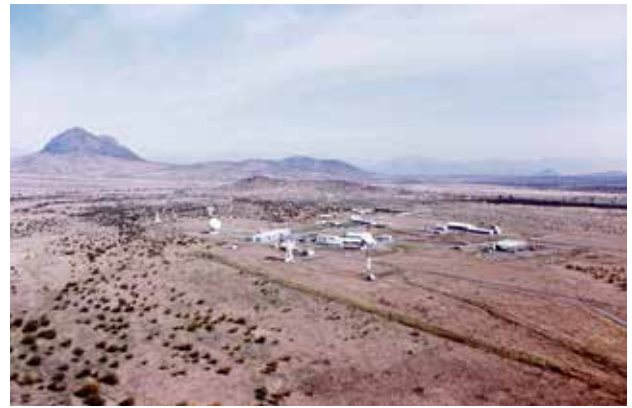
FIG 3 Vista aérea de la estación de monitoreo de satélites NASA, hoy Swedish Space Corporation (SSC), Peldehue, Chile. Posiblemente hacia la década de 1980. / Aerial view of NASA satellite tracking station, current Swedish Space Corporation (SSC), Peldehue, Chile. Fuente / Source: Swedish Space Corporation.
