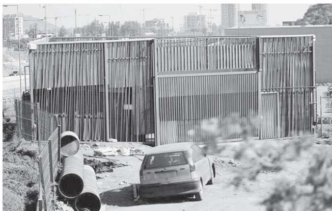
Imagen 3: Centro de operaciones en la comuna de lo Barnechea
