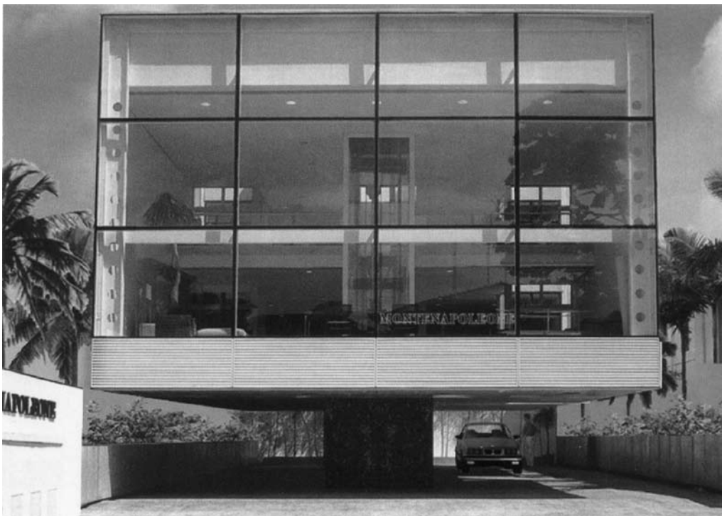
7 Clínica de odontología, Orlandia, 2000, Angelo Bucci, Fernando de Mello Franco, Marta Moreira y Milton Braga (Foto de los autores) Forma intensa –elemental y transparente–, apoyada por el acierto de las soluciones constructivas, demuestra sutilmente la naturaleza no privada del edificio. La caja de vidrio sin los problemas climáticos de muchos de sus predecesores
